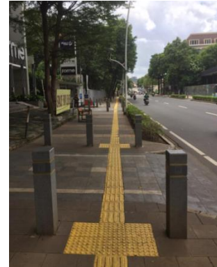
Gambar 11.. Fungsi Block Indicates Stop pada pintu masuk bangunan dan tempat penyeberangan
