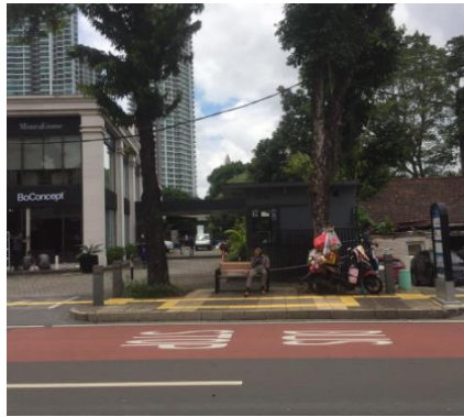
Gambar 12. Fungsi Block Indicates Stop pada halte di jalur pedestrian
