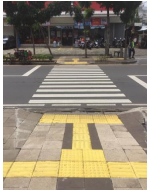
Gambar 11.. Fungsi Block Indicates Stop pada pintu masuk bangunan dan tempat penyeberangan
