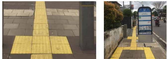
Gambar 10. Block indicates Stop pada pedestrian di Jl. Kemang Raya
