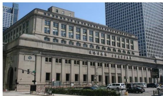
Gambar 3. 5 : Chicago stasiun kereta api Sumber : Google
