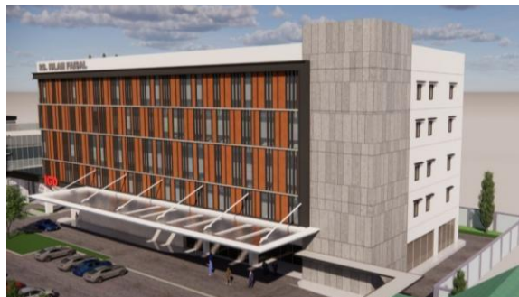
Gambar 4.6 Desain pada dinding Bangunan RS. Islam Faisal Makassar Sumber: Data PT. JFP, 2024
