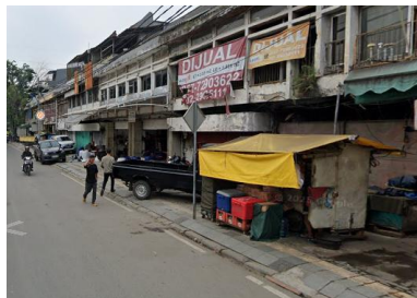
Gambar 4.13 Kondisi jalur trotoar yang menghubungkan zona Sunda Kelapa dengan zona Fatahillah.
