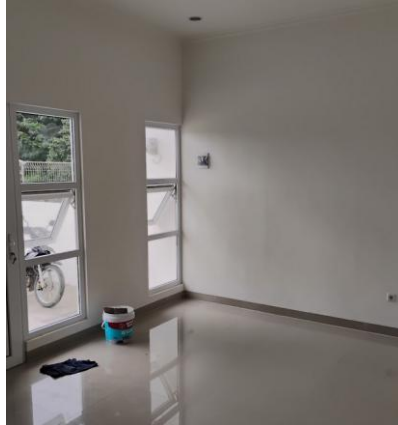
Gambar 8. Tipe Jendela Buka-an pada unit C-08 Sumber: Dokumentasi Penulis 2025
