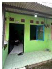
Gambar 5 Area Teras Rumah Kontrakan Pinang II Sumber : Hasil Survey Pribadi
