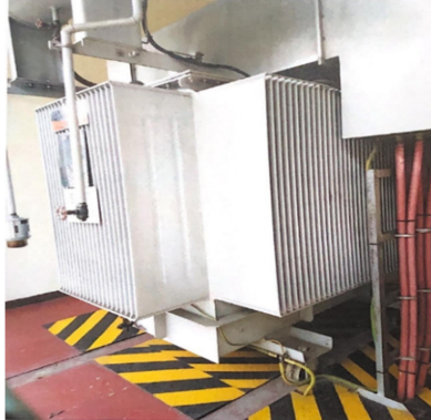
Gambar 2.4 Transformator 20 kV/1200V Gardu Traksi Pasar Minggu.
