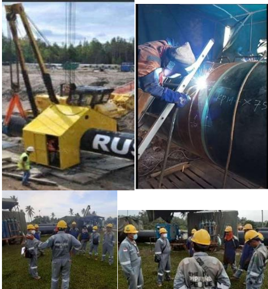
Contoh welding habitat pada proses welding pipa pada pipeline sistem
