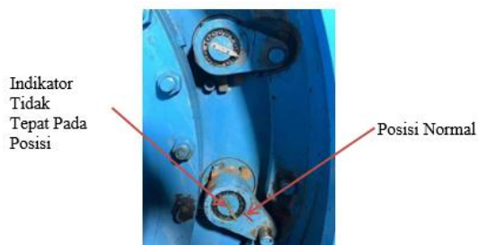
Gambar 3. Indikator guide vane menunjukkan pergeseran dari posisi normal.
